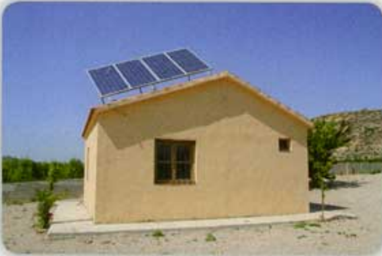
Caseta con panel fotovoltaico y compresor
